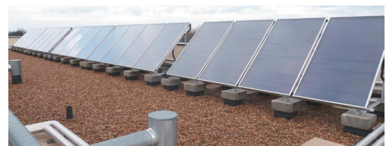
Panneaux solaires en toiture (non intégrés au bâti)
